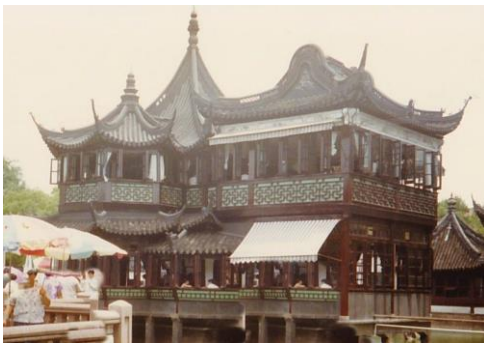
1Fのみならず、2Fでも、多くの窓は全開…
